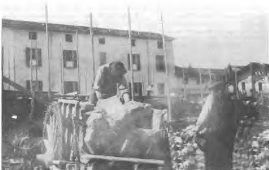
Inizio del secolo scorso: sono appena partiti i lavori per la costruzione della chiesa dell'oratorio
